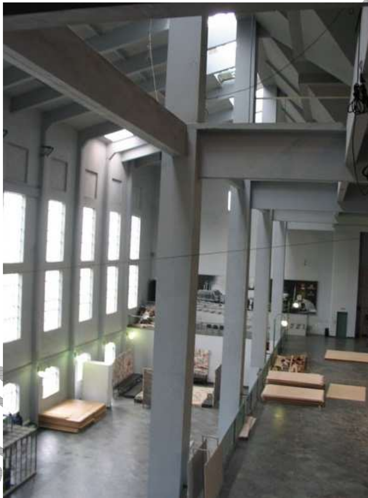
Figura 11 – Interior do GASÔMETRO após fechamento e antes da reforma de requalificação
