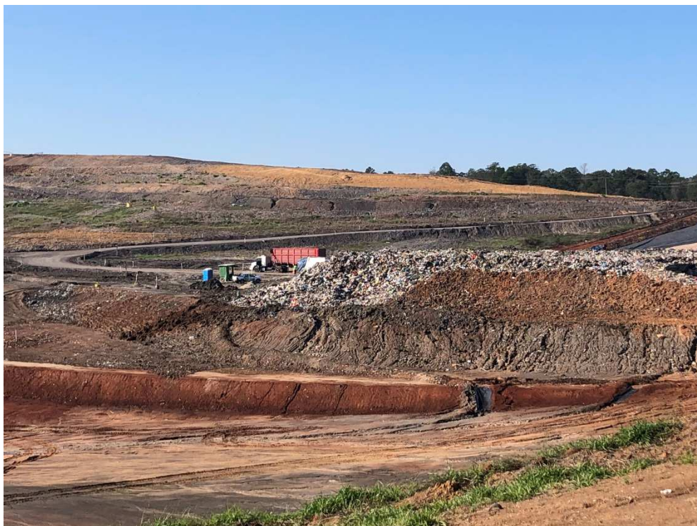
Figura 4.31 – Frente de serviço do aterro sanitário
