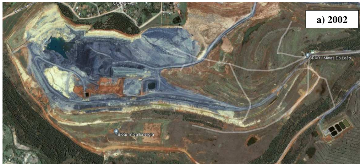
Figura 4.30 – Imagem de satélite do Aterro Sanitário da Central de Resíduos do Recreio, em imagens de (a) 2002, (b) 2012 e (c) 2021
