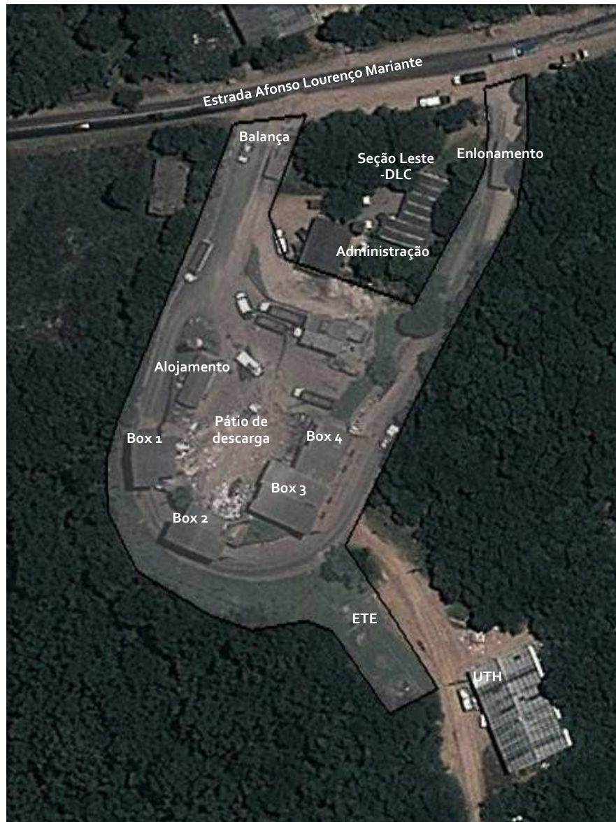
Figura 4.18 – Vista aérea da Estação de Transbordo Lomba do Pinheiro
