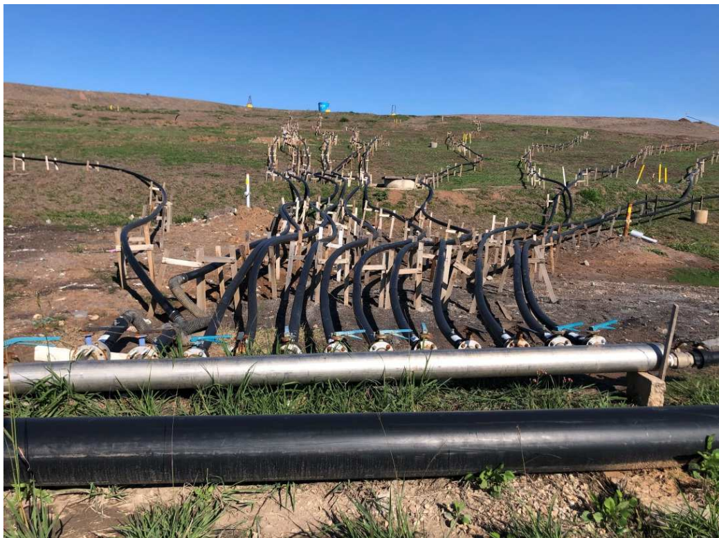
Figura 4.33 – Captação ativa de biogás do aterro
