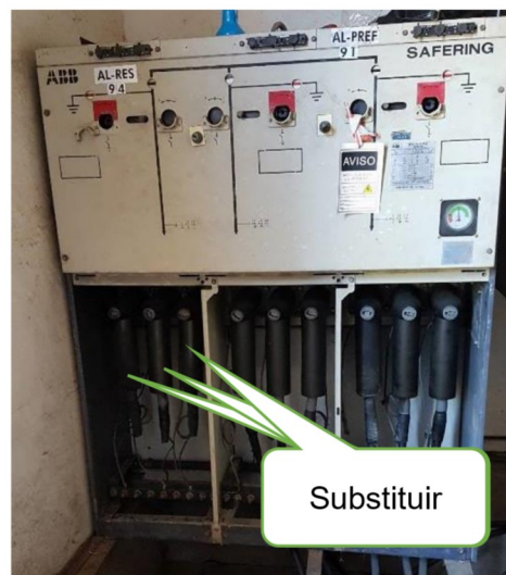
Foto 3. Detalhe interno da chave reversora (não representa situação atual).
