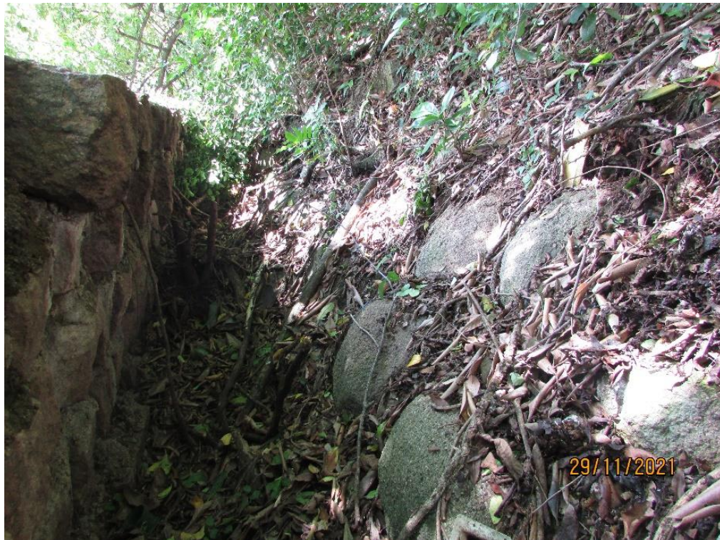
Figura 15. Talude de enrocamento antes do muro de contenção.
