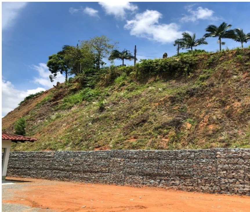
Exemplo de limpeza de talude para aplicação da malha de aço
