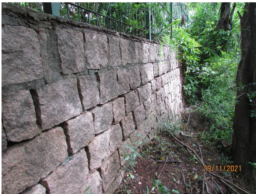
Figura 16. Muro de contenção na Rua Engenheiro Álvaro Nunes Pereira na porção mais baixa.
