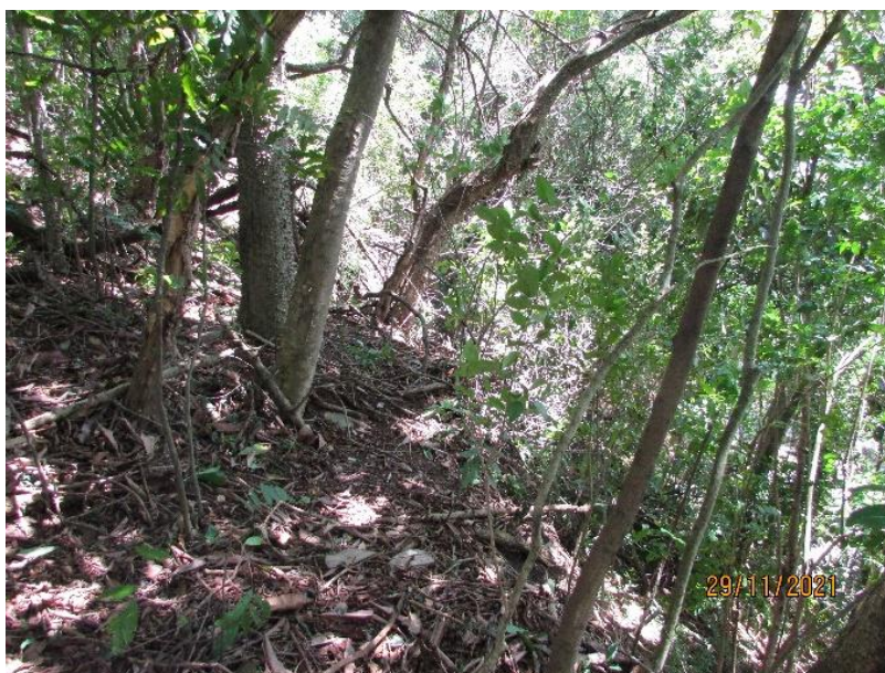
Figura 34 – Detalhe dos vegetais localizados na crista do talude.
