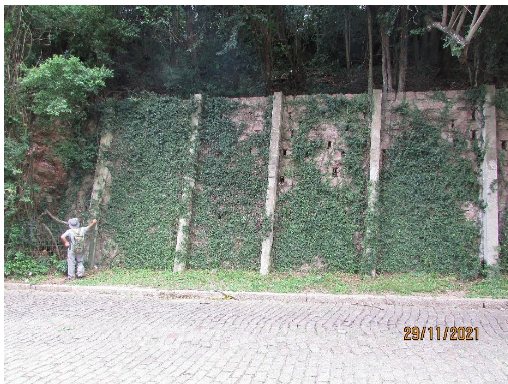
Figura 12. Ponto mais alto do muro com contrafortes de sustentação nos primeiros 19 metros.
