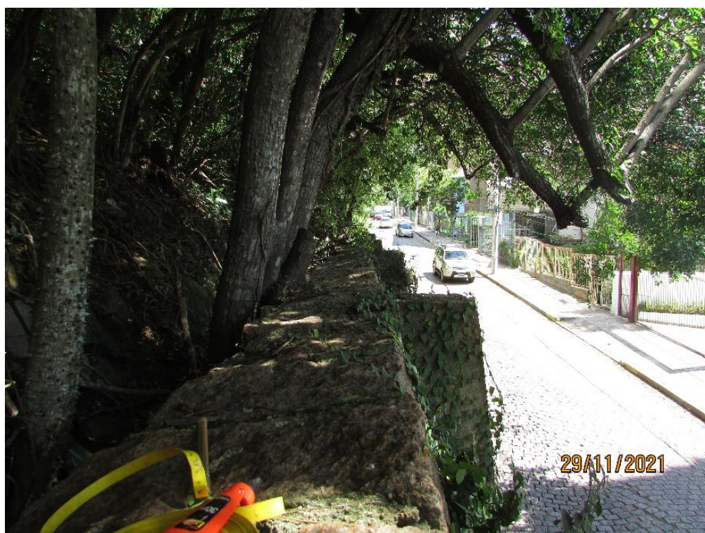
Figura 14. Vista do topo do muro.
