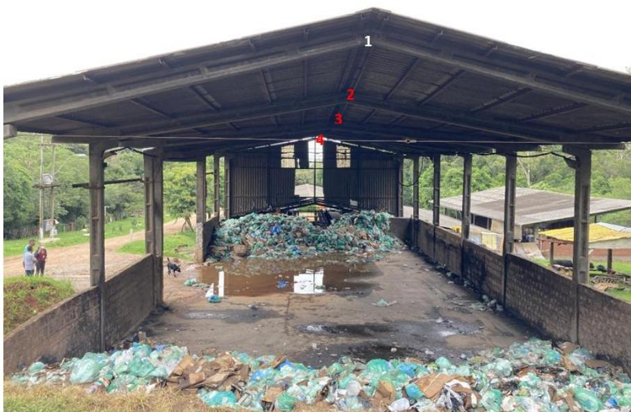
Figura 2 - vista externa - abertura de pernas das tesouras 2, 3 e 4.
