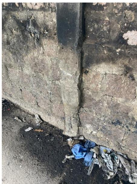
**Figura 6 - vista interna - marcas de carbonização nos pilares que já apresentavam danos causados pela operação.**
