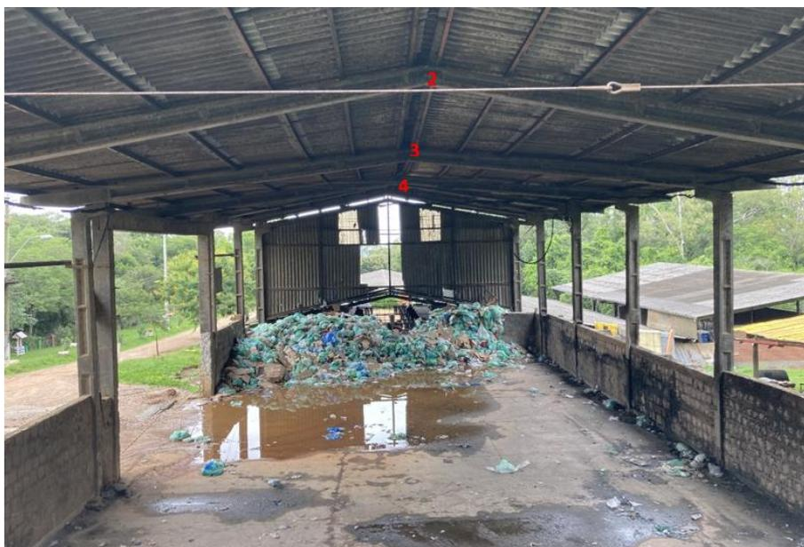
Figura 3 - vista externa - abertura de pernas das tesouras 2, 3 e 4.
