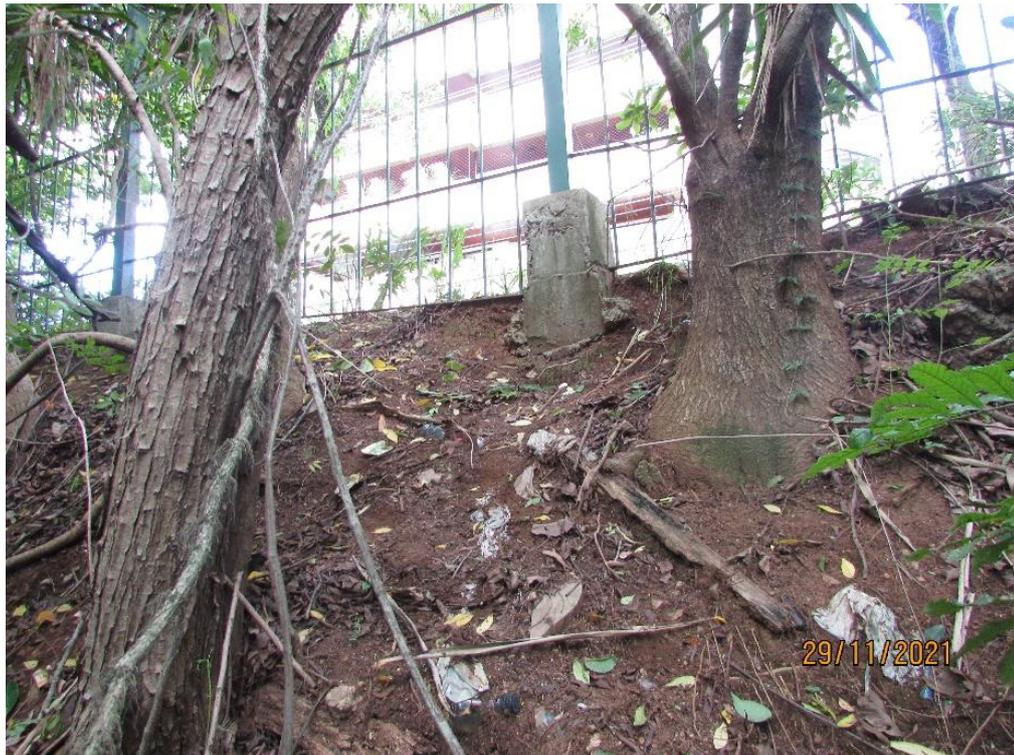
**Figura 17. Ponto com a crista do talude próxima a calçada expondo uma fundação de concreto da grade por conta da lixiviação lenta de partículas de solo.**
