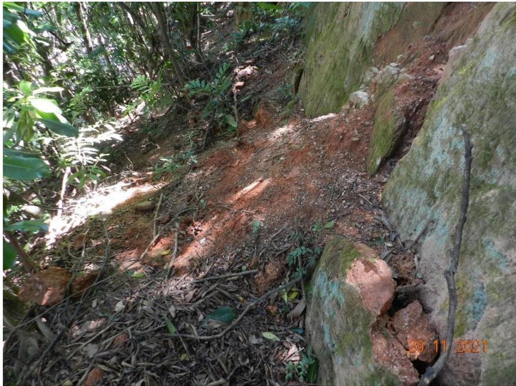
**Figura 2 - Rocha granítica com alto grau de alteração depositando lentamente no pé do talude o material desprendido do maciço**
