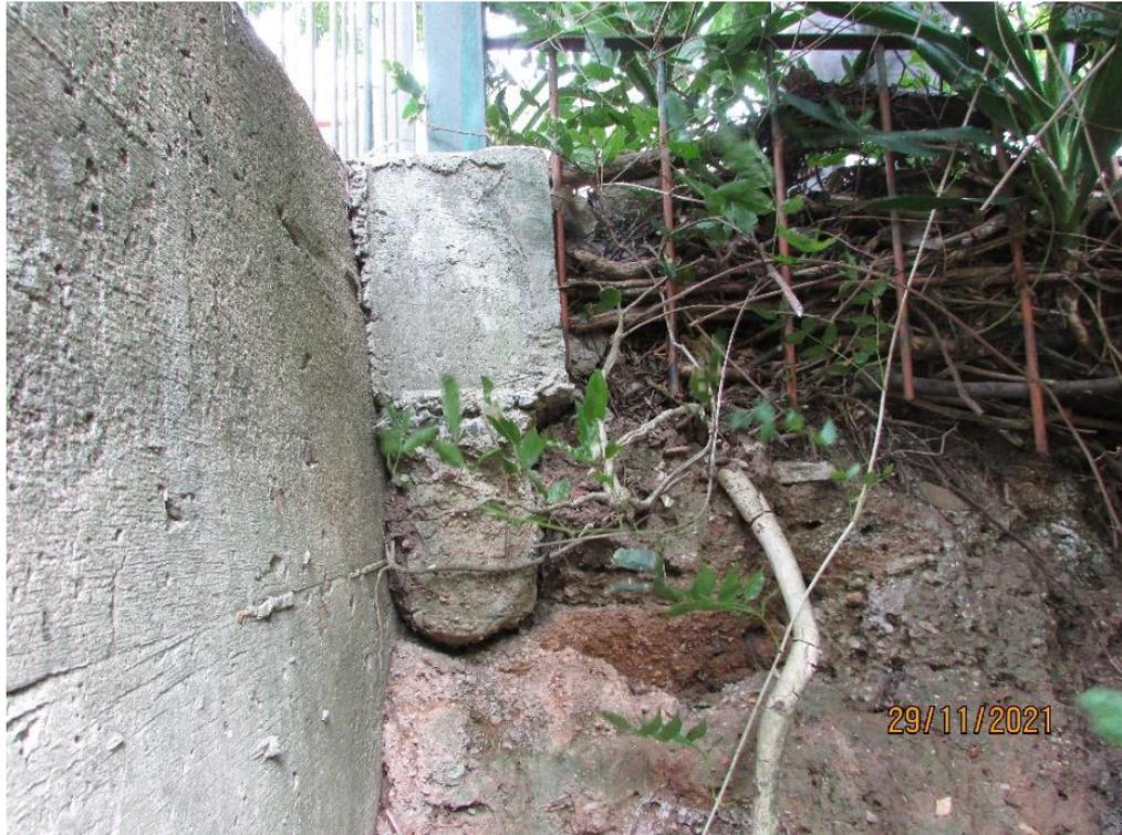
**Figura 18. Extremo Norte da área, na divisa com um prédio residencial, o talude tem declividades próximas a 90° e o solo nesse ponto já foi parcialmente lixiviado.**
