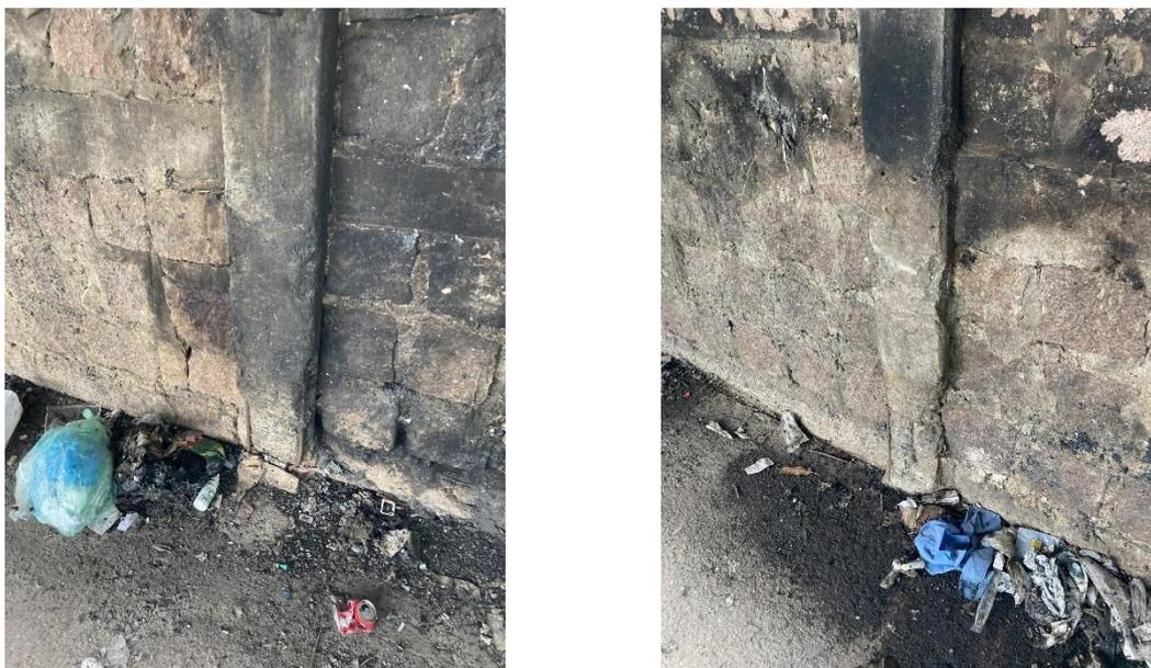
**Figura 6 - vista interna - marcas de carbonização nos pilares que já apresentavam danos causados pela operação.**
