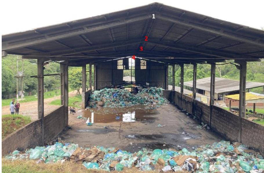
Figura 2 - vista externa - abertura de pernas das tesouras 2, 3 e 4.
