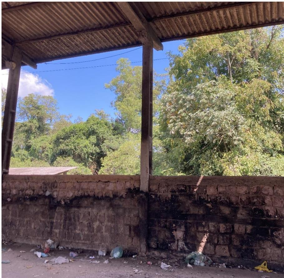
**Figura 5 - vista interna - marcas de carbonização.**
