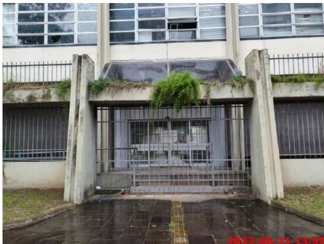
Foto 3 – Acesso principal ao prédio
