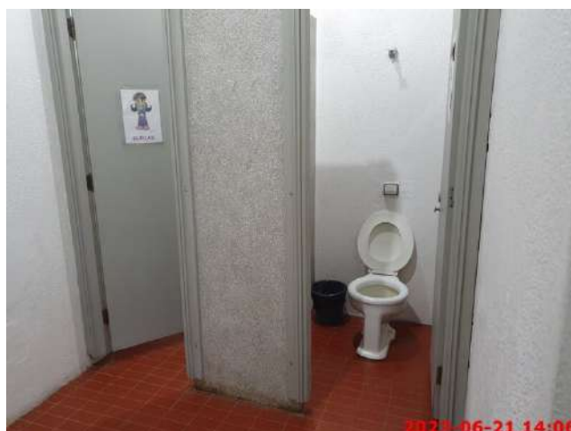
Foto 12 – Aspectos Internos – Térreo
