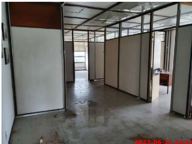
Foto 21 – Aspectos Internos – 3º Pavimento
