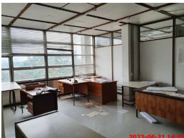
Foto 29 – Aspectos Internos – 5º Pavimento
