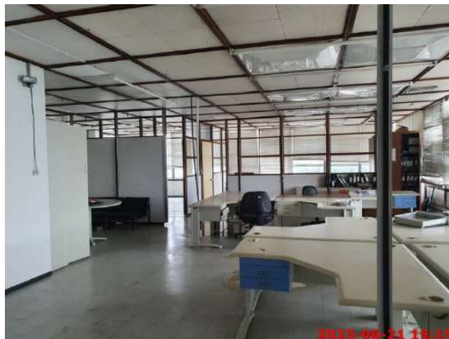
Foto 34 – Aspectos Internos – 6º Pavimento
