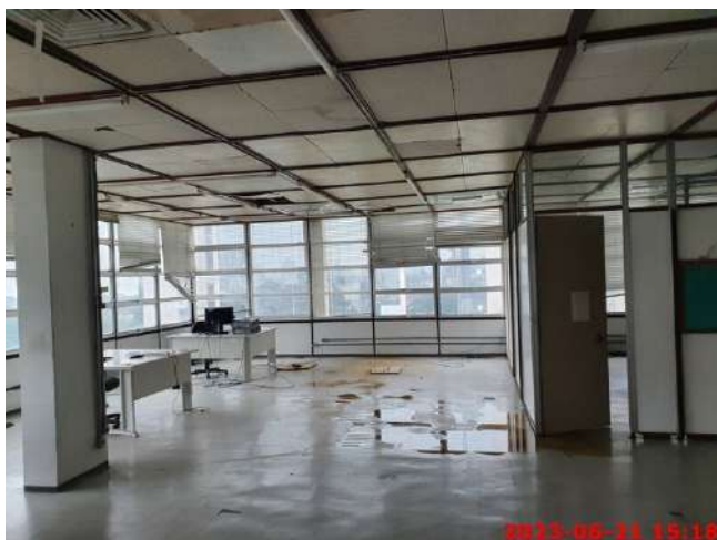
Foto 35 – Aspectos Internos – 6º Pavimento
