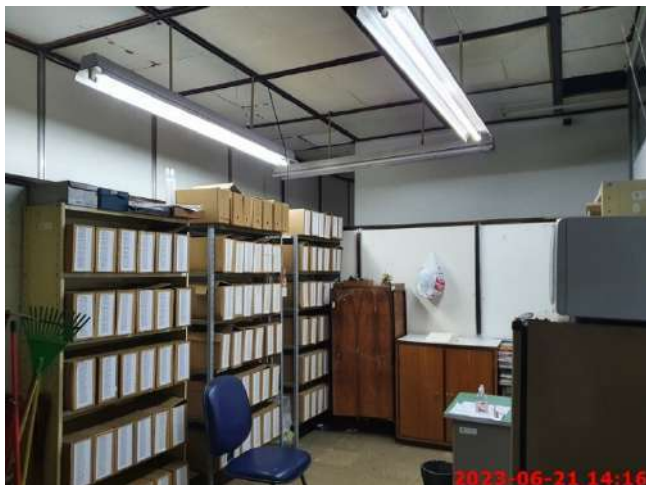
Foto 9 – Aspectos Internos – Térreo
