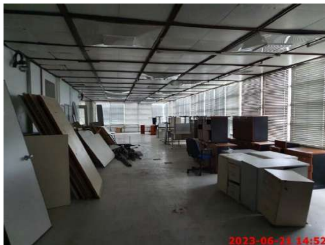
Foto 26 – Aspectos Internos – 4º Pavimento
