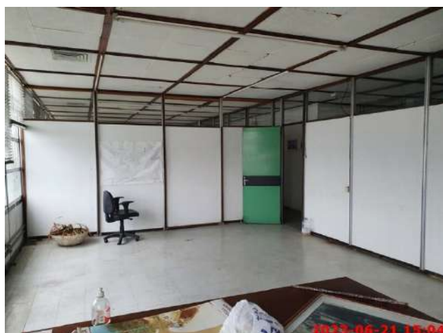
Foto 30 – Aspectos Internos – 5º Pavimento
