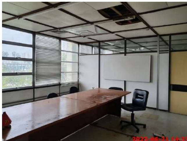
Foto 22 – Aspectos Internos – 3º Pavimento
