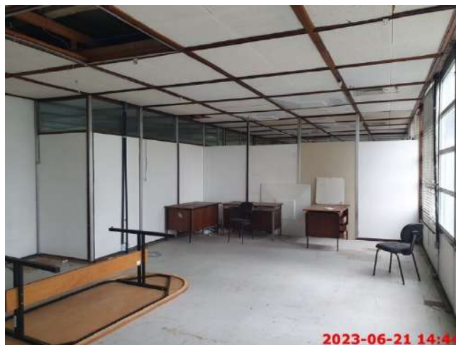
Foto 20 – Aspectos Internos – 3º Pavimento
