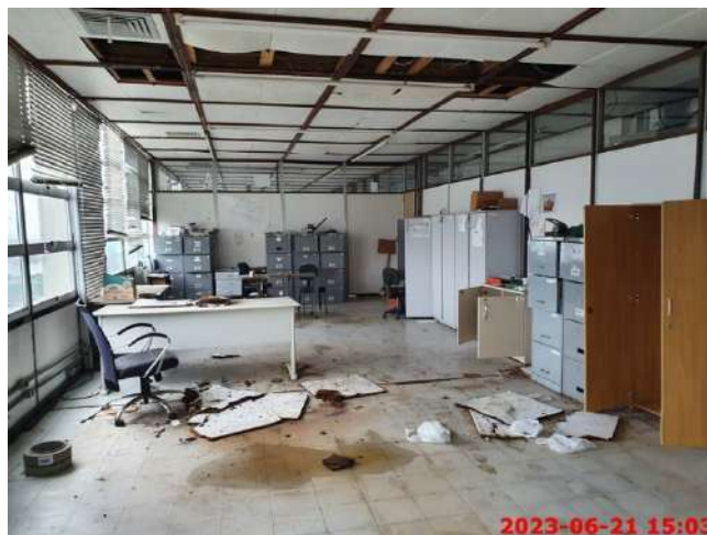
Foto 32 – Aspectos Internos – 5º Pavimento
