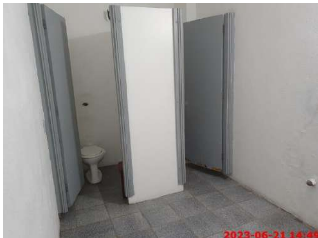
Foto 28 – Aspectos Internos – 4º Pavimento
