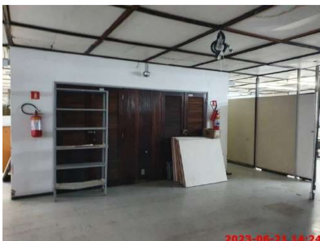
Foto 17 – Aspectos Internos – 2º Pavimento
