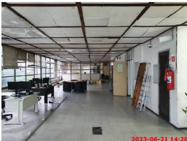
Foto 13 – Aspectos Internos – 2º Pavimento
