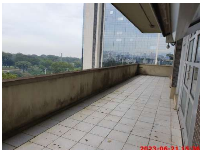
Foto 42 – Aspectos Internos – 7º Pavimento
