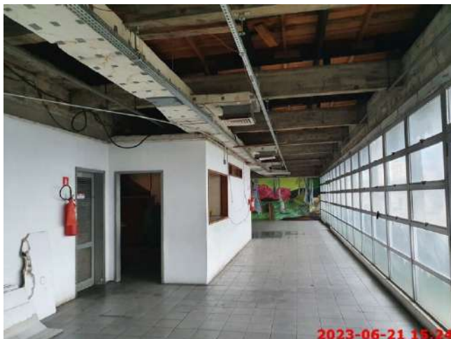
Foto 39 – Aspectos Internos – 7º Pavimento
