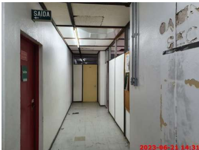
Foto 19 – Aspectos Internos – 3º Pavimento
