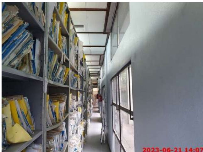
Foto 7 – Aspectos Internos – Térreo
