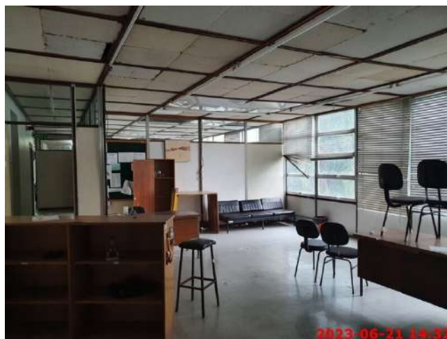
Foto 24 – Aspectos Internos – 3º Pavimento
