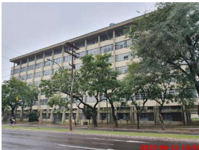
Foto 1 – Fachada Edificação Avenida Borges de Medeiros
