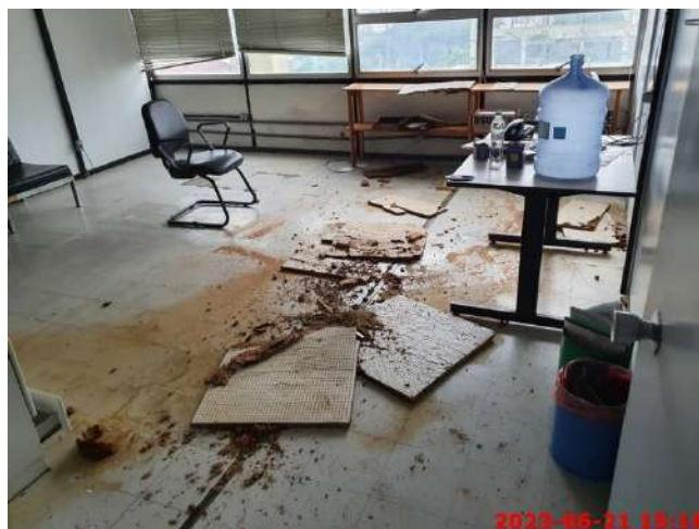
Foto 36 – Aspectos Internos – 6º Pavimento
