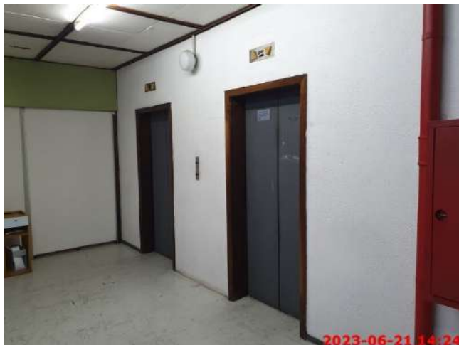
Foto 15 – Aspectos Internos – 2º Pavimento
