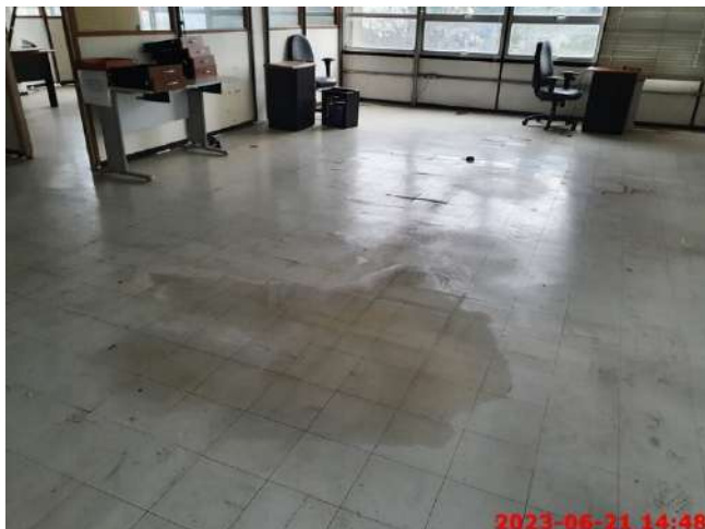
Foto 27 – Aspectos Internos – 4º Pavimento
