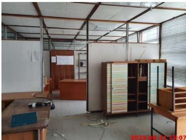
Foto 31 – Aspectos Internos – 5º Pavimento
