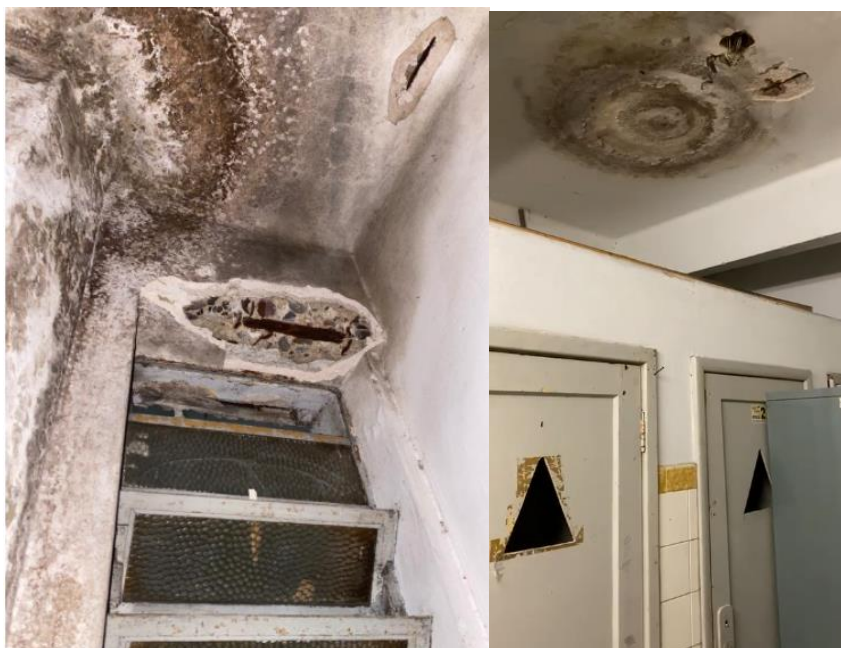
Foto 6 – armadura exposta em laje e viga no segundo pavimento
