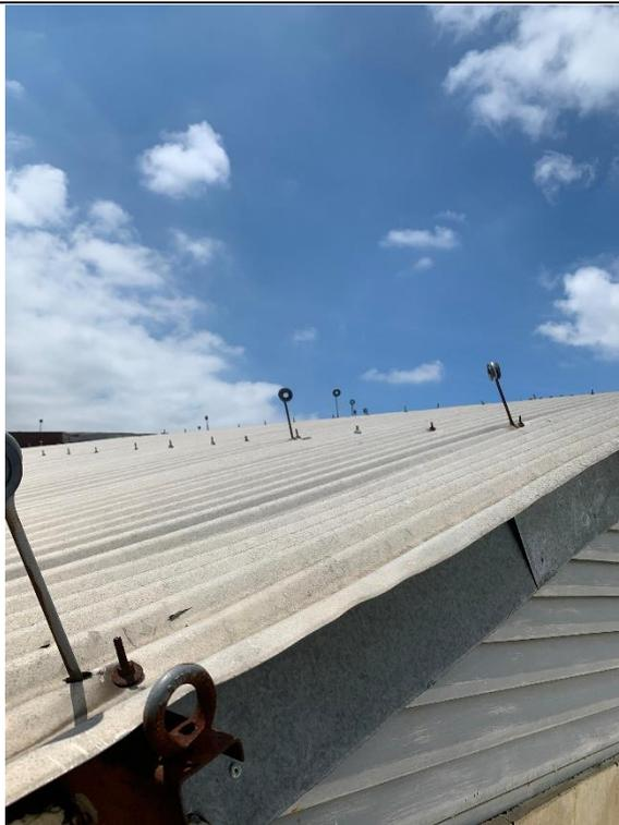
**5.3.7** – Suportação da malha do subsistema de captação do SPDA sobre outro ponto do telhado, também sem nada de cabos restantes.
