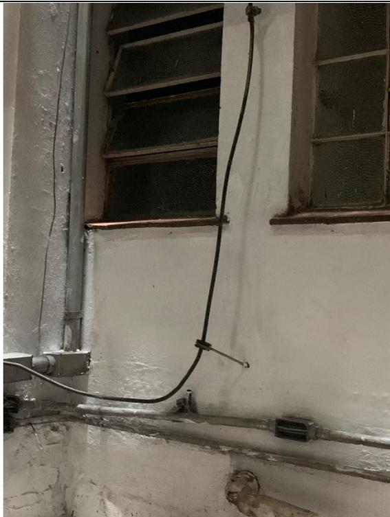
**5.3.2** – Um dos cabos do subsistema de descidas do para raios. Recomenda-se que as descidas sejam o mais lineares possível até atingir o subsistema de aterramento.
