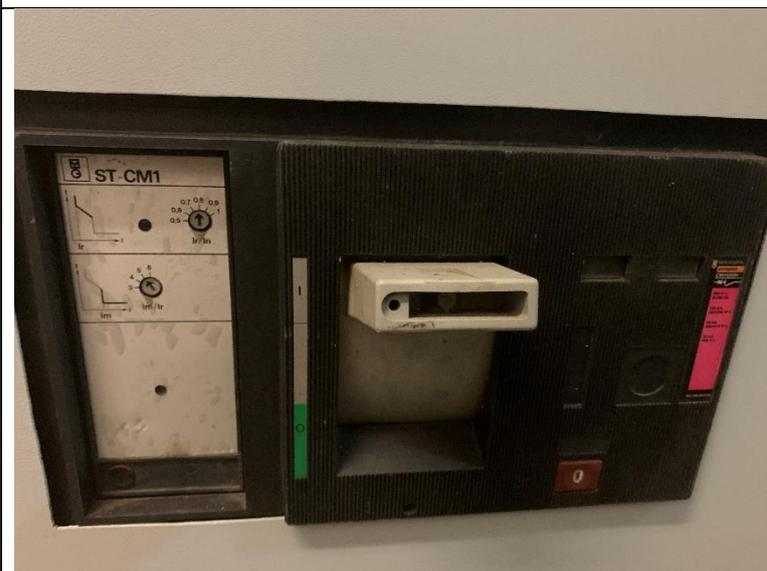
**5.1.15** – Detalhe do modelo de disjuntor 1200A presente como disjuntor geral nos três QGBT.
