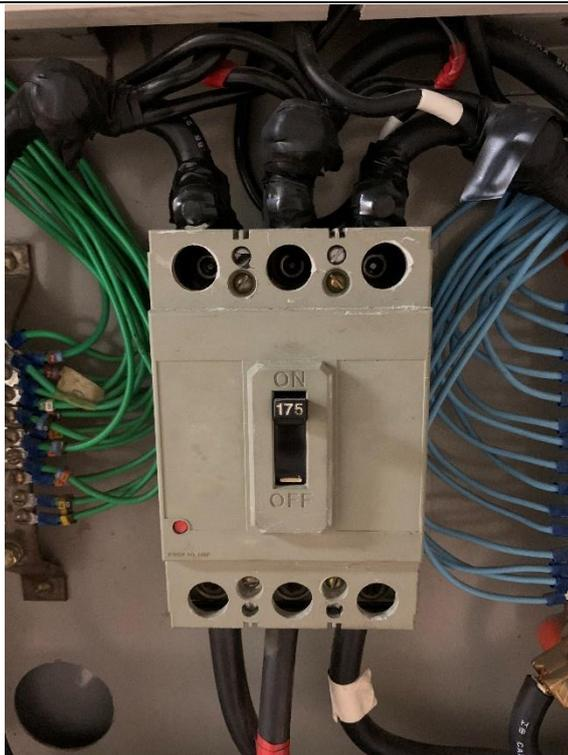
**5.5.2** – Emendas na saída do disjuntor, distribuindo para os diversos barramentos e também para o painel ao lado.
