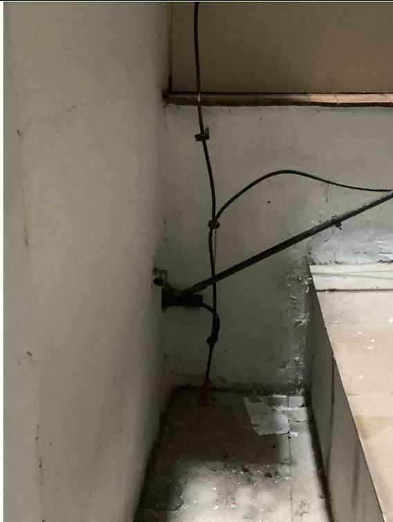
**5.3.3** – Neste ponto, segundo o técnico da manutenção do prédio, está uma das conexões com o subsistema de aterramento.
