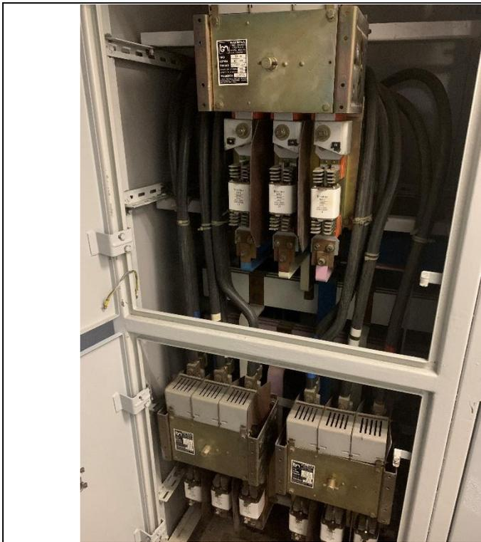
**5.1.1** – Chaves seccionadoras Beghim de conexão da baixa tensão vinda da subestação subterrânea. Instalação robusta e em boas condições apesar de visivelmente ter sido concluída há décadas. Não há problemas em manter esta instalação. Está suprindo bem e em segurança o prédio. Deve receber manutenção periódica com termografia, reaperto, limpeza, lubrificação e testes de isolamento.
