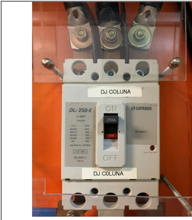
**5.4.3** – Detalhe de um disjuntor de coluna, novamente do quadro do item 5.4.1, este para a saída da coluna para o quadro do pavimento superior. Agora a capacidade é de 250A e os cabos que alimentam o quadro do pavimento superior são de capacidade inferior aos que chegam vindos do quadro do pavimento inferior.
