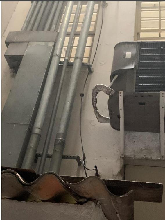
**5.3.4** – Esta foto de uma prumada de cabo de cobre nu demonstra um dos pontos onde este cabo recebe uma derivação e entra por uma tubulação para o interior da edificação. Na próxima foto pode-se ver que logo mais acima isso ocorre novamente e assim por diante até atender a todos os pavimentos.
