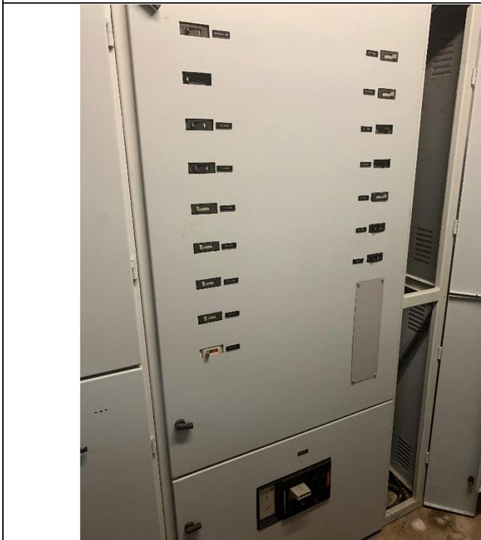
**5.1.4** – QGBT de tomadas. Painel é robusto e está em boas condições. Da mesma forma que para as chaves seccionadoras, quadros principais devem passar por análise termográfica periódica para identificação de pontos quentes, limpeza e reaperto de conexões. Os disjuntores gerais devem ter seus mecanismos de disparo testados. Abaixo na mesma imagem o disjuntor geral de 1200A.
