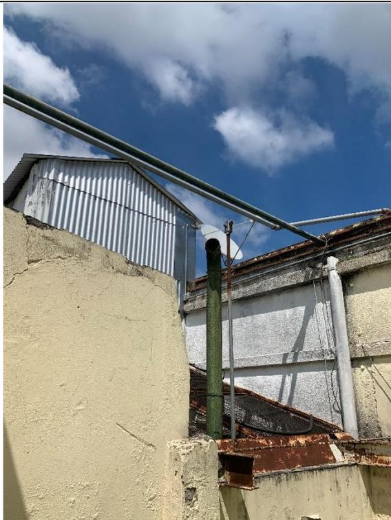
**5.3.8** – Existem claramente diversas estruturas metálicas desprotegidas na cobertura no que diz respeito a descargas atmosféricas.
