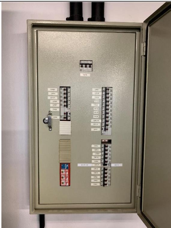
**5.5.4** – Quadro com caixa de chaparia robusta, espelho interno adequado, DPS. É um bom quadro, mas como é comum acontecer em casos como este, o reaproveitamento deste tipo de material acaba trazendo mão de obra elevada, acabamento deficiente, improvisos. Os quadros terminais serão projetados para serem novos.
