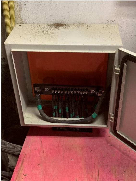
**5.3.1** – BEP (barramento de equalização principal) que fica no interior da edícula por onde passam os alimentadores dos pavimentos. Está bem instalado e dele derivam os cabos para o aterramento dos quadros dos pavimentos.
