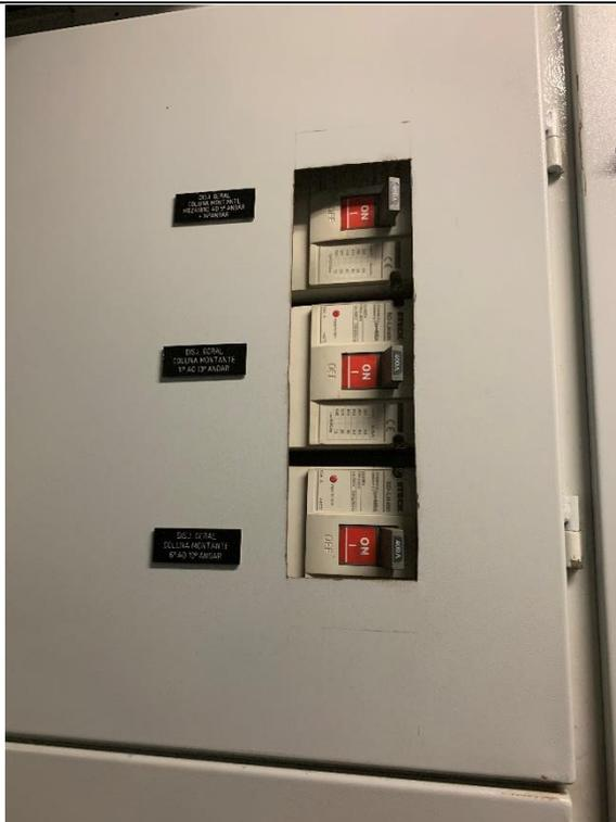
**5.1.5** – Disjuntores que alimentam a coluna de alimentação da climatização nos andares, situados no QGBT de ar condicionado e elevadores. Nota-se que o recorte da porta do painel não resultou em encaixe perfeito, mas a instalação é de boa qualidade.
