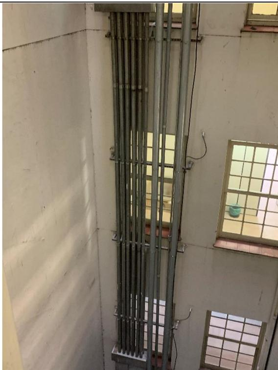
**5.2.2** – Vista mais próxima das tubulações que formam as colunas montantes de iluminação e tomadas e climatização. As tubulações mais à esquerda com diâmetro menor são as da coluna de iluminação e tomadas. Já as mais à direita são as que compõem a distribuição de energia para os quadros de climatização nos andares. Tubulações foram bem instaladas e estão em boas condições.
