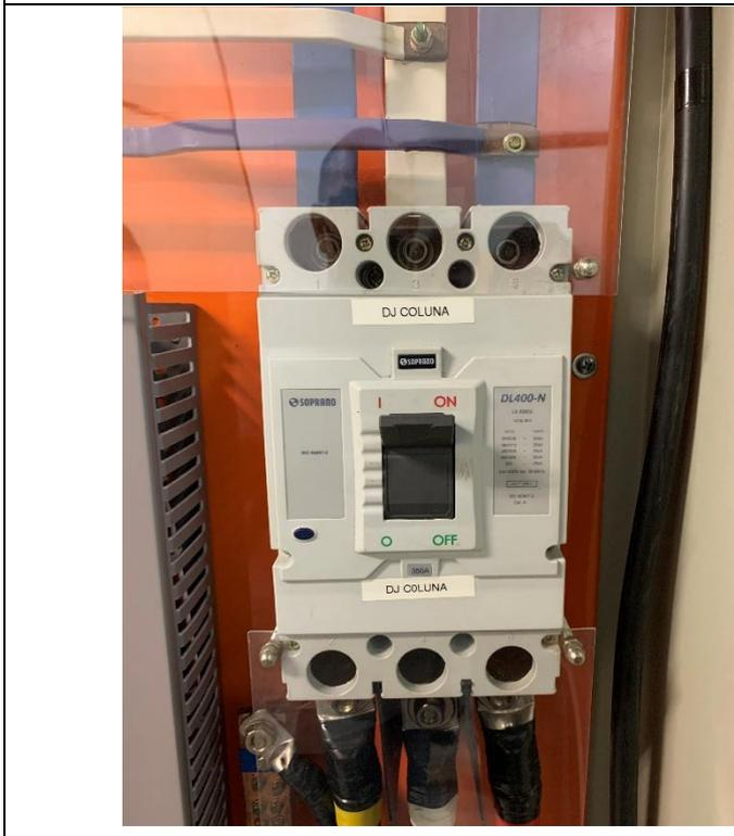
**5.4.2** – Detalhe de um disjuntor de coluna, do quadro do item 5.4.1, que servirá como exemplo neste relatório. Nota-se que os cabos vêm do quadro do pavimento inferior e alimentam um disjuntor de capacidade 350A, que por sua vez alimenta um barramento de onde deriva o setor do quadro destinado a atender os circuitos do andar.
