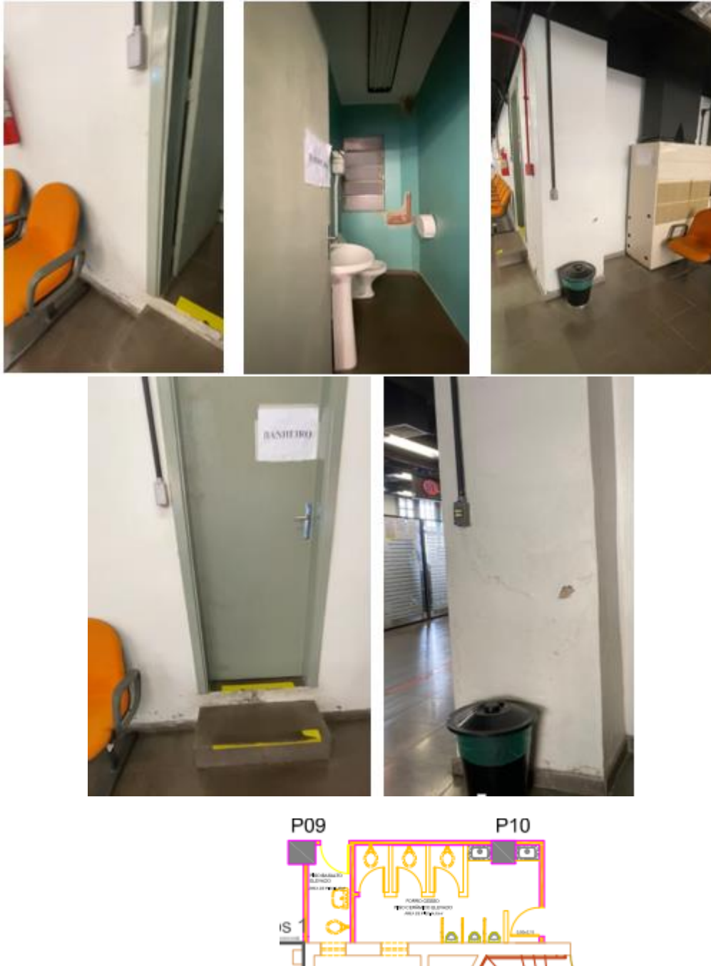
Figura 17 – Identificação de ponto de eflorescência
