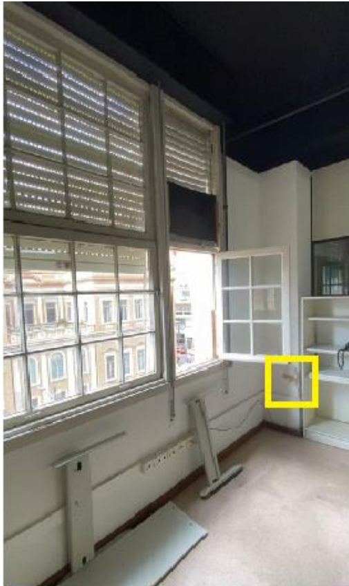
Figura 19 – Abertura 24 e Pilar 35 com infiltração
