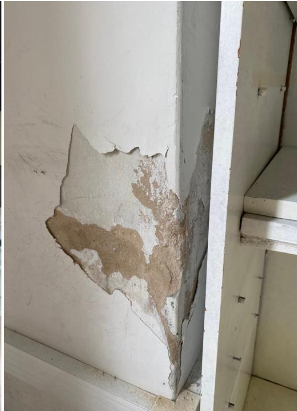
Figura 20 – Detalhe do Pilar 35 com infiltração
