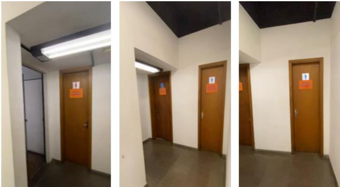
Figura 14 - Rebaixo no teto localizado nos banheiro de uso privativo
