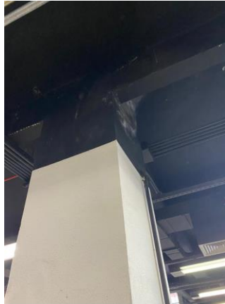
Figura 18 – Eflorescência no Pilar 09 no pavimento térreo
