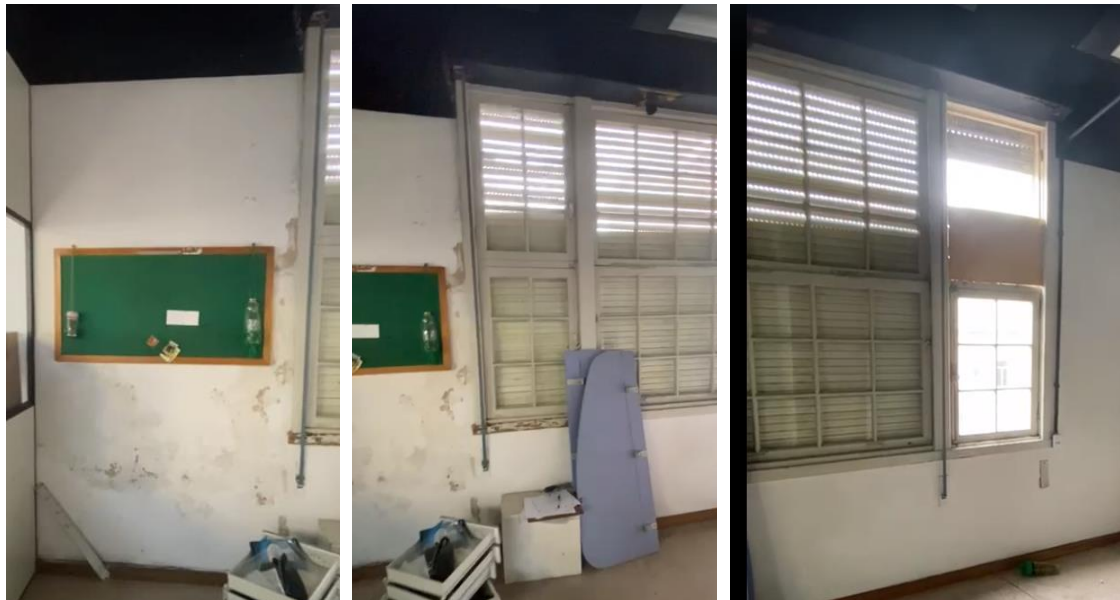
Figura 21 –Pilar 35 e parede com infiltração, detalhe da abertura 21 apodrecida com abertura de ar condicionado de parede
