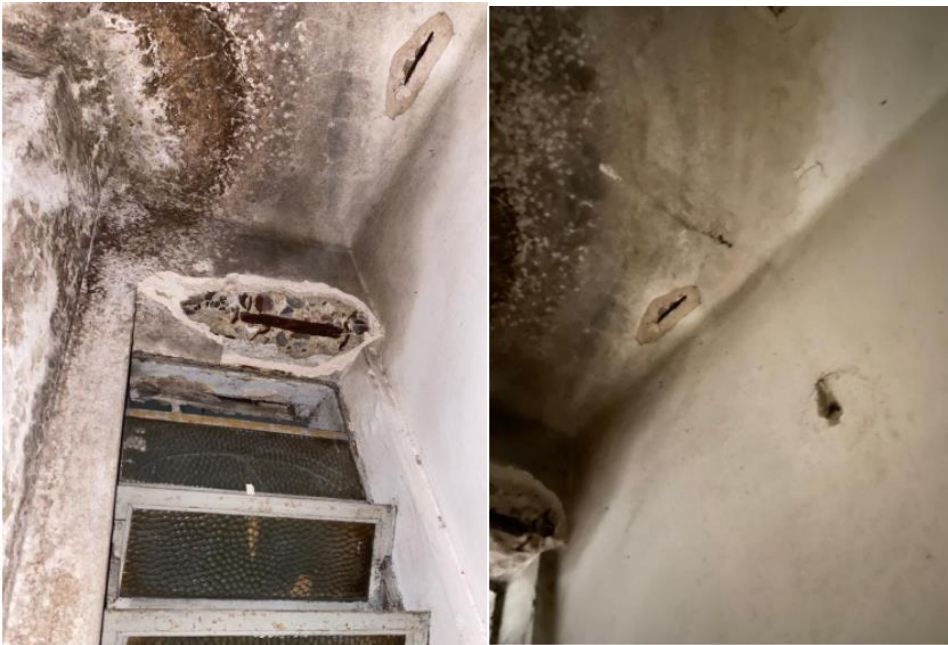
Figura 22 – Ferro exposto em viga e lajes – segundo pavimento
