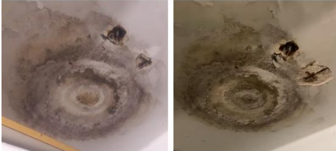
Mancha de umidade na face inferior da laje do 3º pavimento
