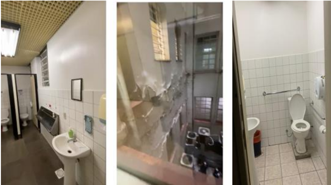
Figura 24 – Fotos dos sanitários no 3º pavimento
