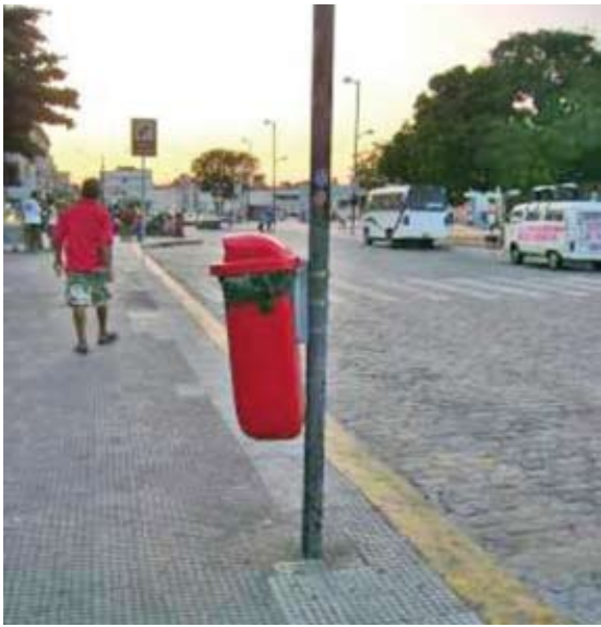
Foto 05 – Lixeira suspensa sem piso tátil de alerta
