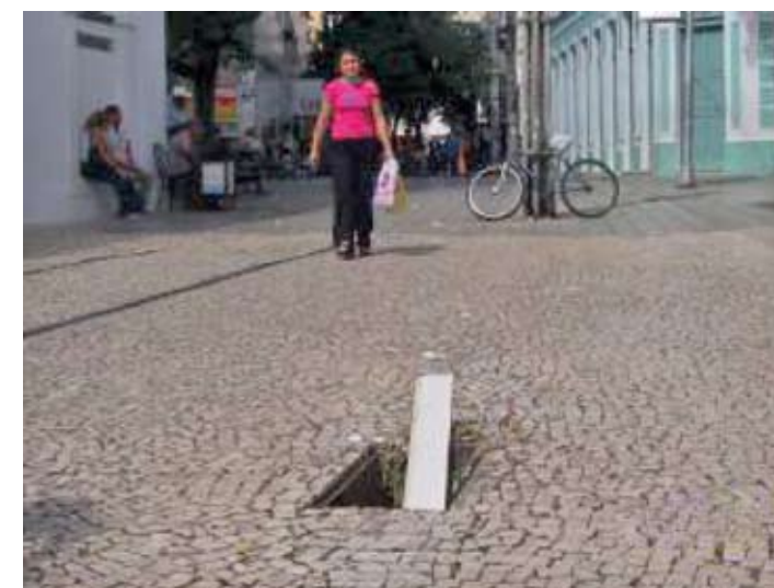
Foto 01 – Caixa de inspeção (tampa retirada)
