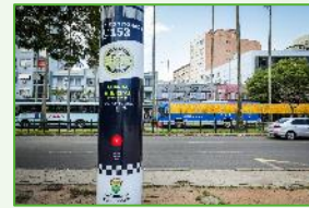
Instalação de Totens de Segurança
