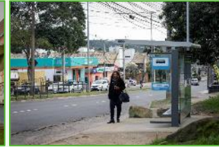
Abrigos de Ônibus
