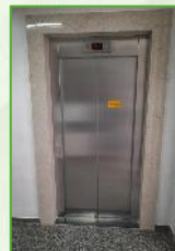
Substituição dos elevadores HMIPV
