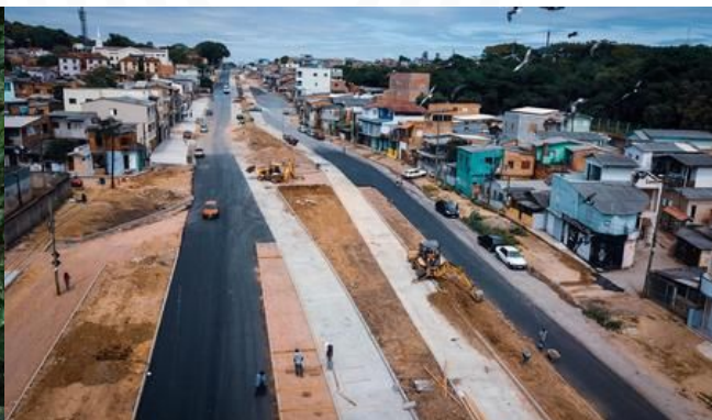
Reurbanização da Vila Tronco
